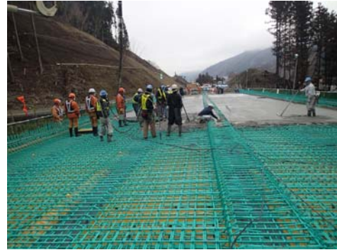
写真-4 向定内橋における施工状況
