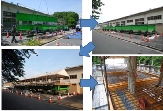
写真-2 鋼桁の架設から型枠・配筋まで
