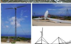
日本の市民共同発電技術は、同様の気候にある韓国にはほぼそのまま技術移転することが可能である。一例をあげると、農地での太陽光発電では耕作とパネル設置を共用できる「ソーラーシェアリング」が行われており、韓国の農地でも応用可能である。また、台湾、ベトナムを高温地域では、薄膜耐熱太陽光パネルを設置することでパネル表面温度が上昇しても、高い発電効率を確保することが可能である。2009年から沖縄離島地域で進む可倒式風車による発電は、同様に台風が多発するベトナム、台湾でもわめて効果的な発電方式であり、すでにトンガに
