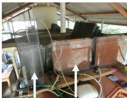
混合曝気槽 電解槽
