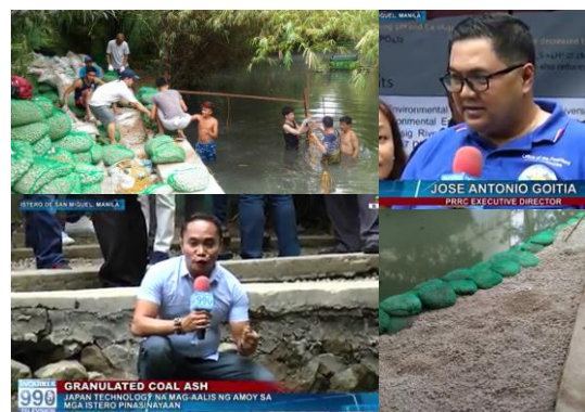
図-2 浄化構造体の構築状況とフィリピン TV で日本の調査対象海域の概技術として紹介（PRRC、UPD、広大で共同して構築、構築は日本と異なり自治体から雇用されている若者が実施する。右上は PRRC executive director）
