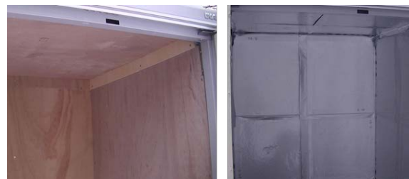
図-5 断熱施工前(左)と施工後(右)の壁面
