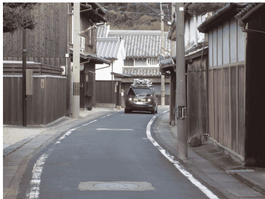
図3 MMSによる調査
