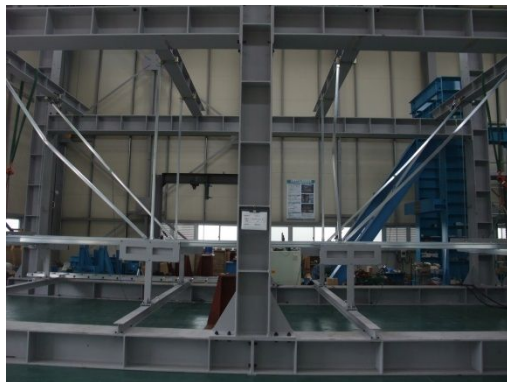
写真 3 モデル 1 の終局状況 (部材の座屈)
