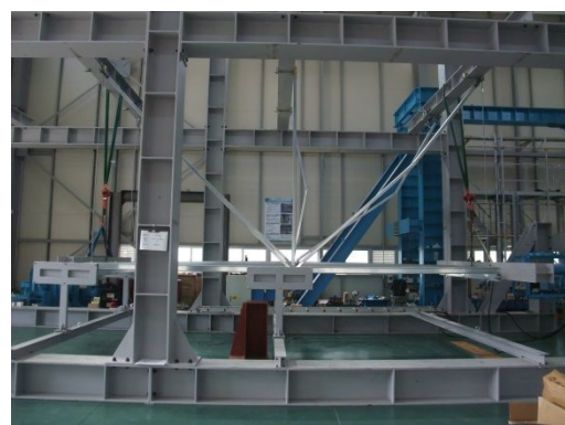
写真 4 モデル 4 の終局状況 (部材の座屈)
