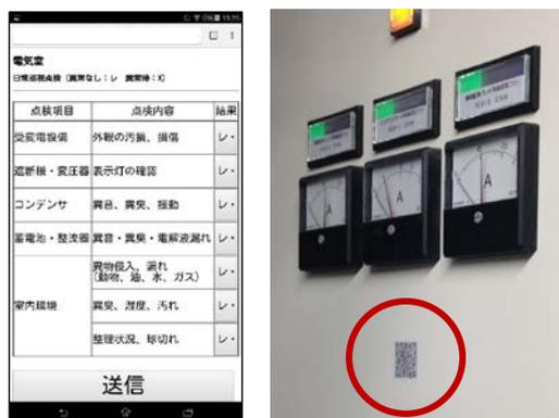
図6 日常点検業務の電気室の点検結果入力ページと機械室内のQRコード
