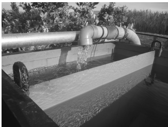
図 4 揚水時の状況（取水強度 100m 3 /day）
