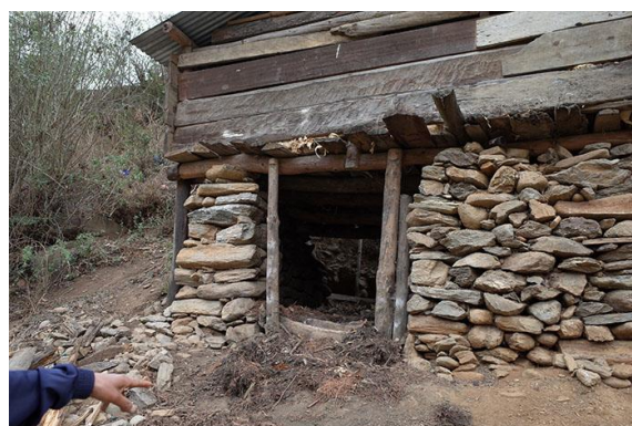
図 8 ディランモンパの伝統的な高床式のトイレ。住居と離れてトイレがある。トイレ下ではブタが飼われている (2017 年)
