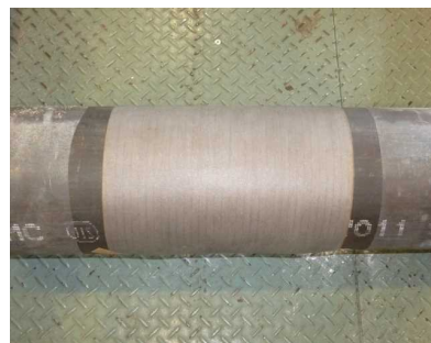
(c) 鋼管への貼付状況
