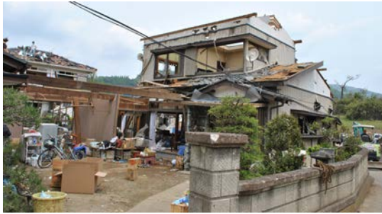
図1：被害連鎖により破壊したと予想される屋根構造用合板破壊
