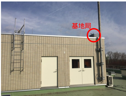
図 1 基地局の設置場所（5 階の屋上）
