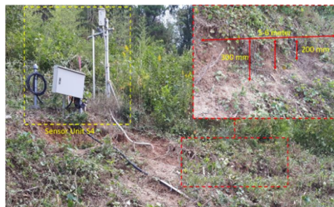
Fig.6 S4ユニット付近で観測された物理的変形
