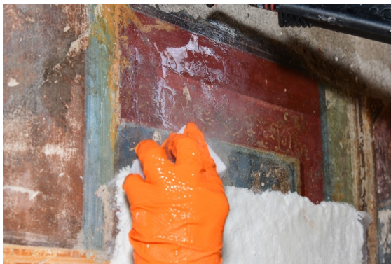
図4 高圧スチームによる蜜蝋の除去
