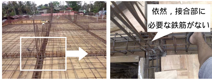
写真2 Padang市の建設現場(2014年)
