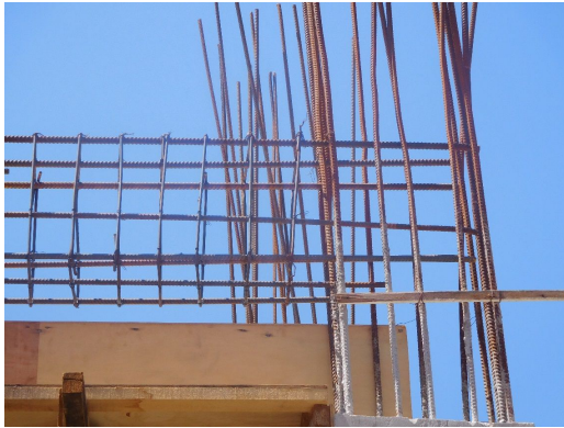
写真3 直線定着された梁主筋
