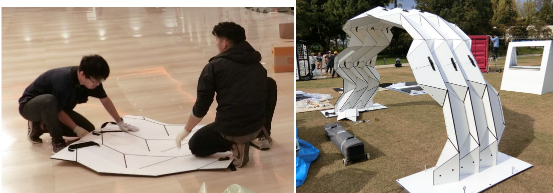
図3：折り線加工を施したサンドイッチパネルから展開するアーチ構造
