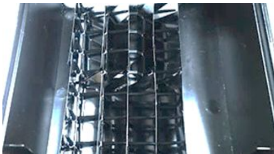
写真 1 設置したステンレス板の様子
