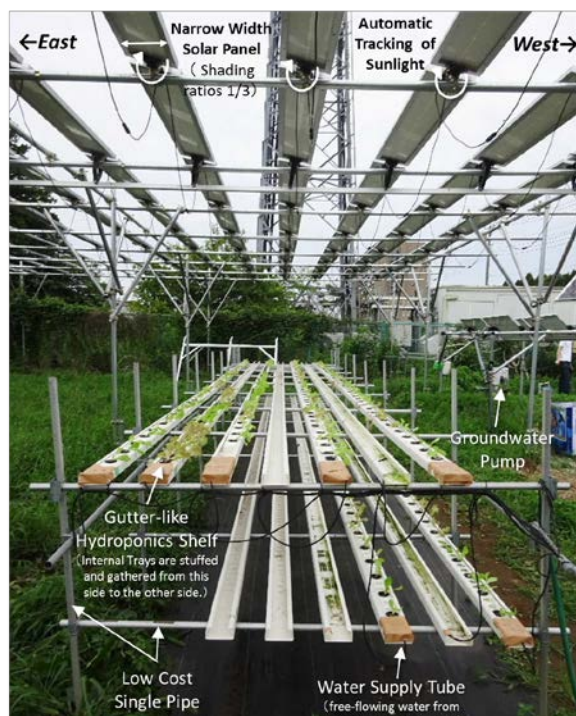
(a) 非養液型桶式水耕方式を用いた高架型 SS 設備
