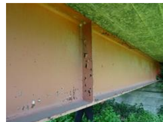
図4 試験対象橋の鋼桁部<塗装状況>
