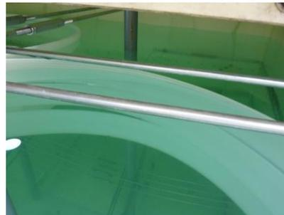
写真 3-2 スロッシング用制振装置の浮体状況
