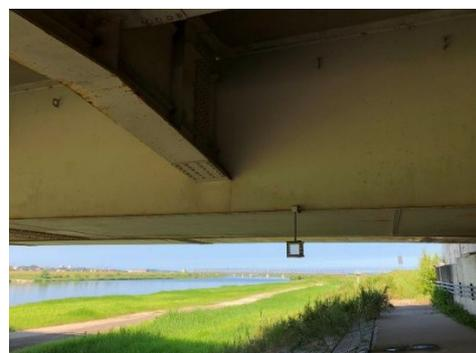
図 2 補修ガーゼの設置状況 (古志大橋)
