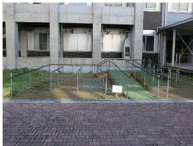
図6 屋外歩行施設修繕施工完成後 (2017年11月)
