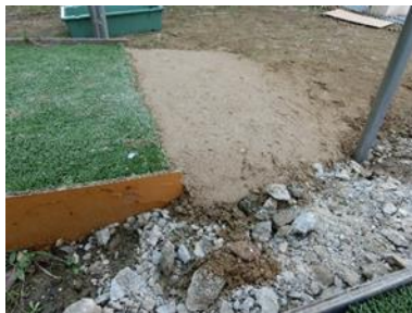
図5 12%勾配の傾斜部の盛土施工
