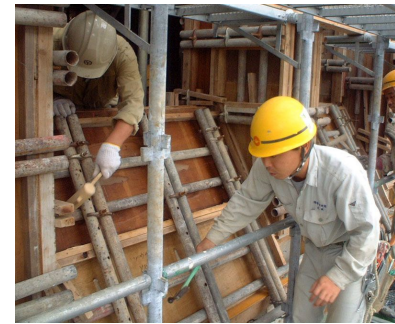
写真2 コンクリートの打込み確認状況の例
