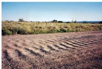
図-2 未舗装路面の周期的凹凸
