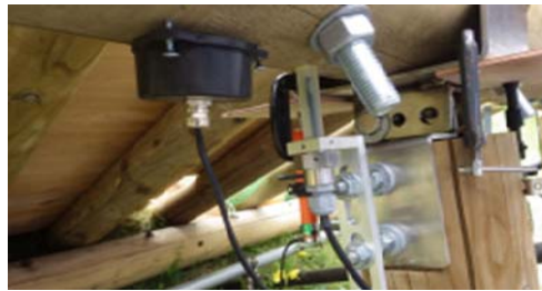
(b) 計測器の設置状況
