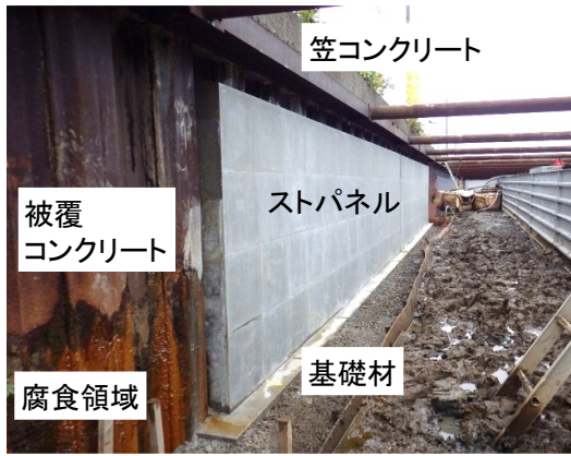
図-4 鋼矢板 - コンクリート複合材 (実構造物での試験施工状況)
