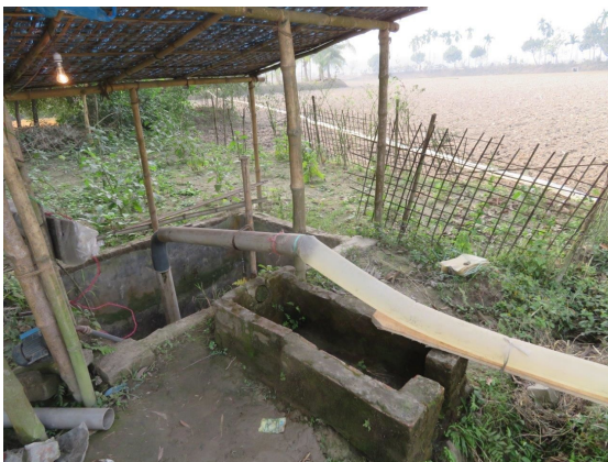
写真 1: 不圧帯水層からの揚水ポンプ (左) およびホースで給水される養魚池 (右)
