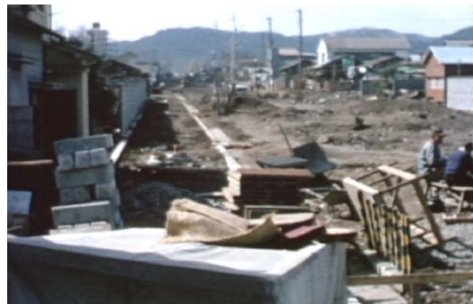
図1 甲州街道バイパス工事の様子（『私達の八王子』より）
