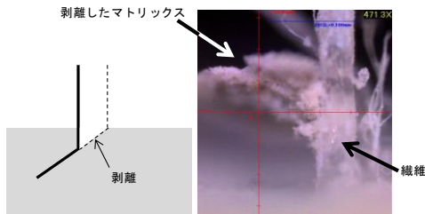
図6 埋込口周辺の剥離
