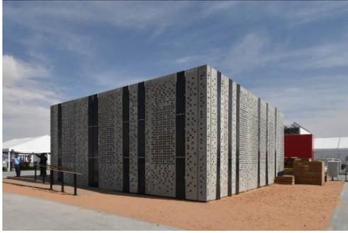
図2 建材一体型 PV の事例
