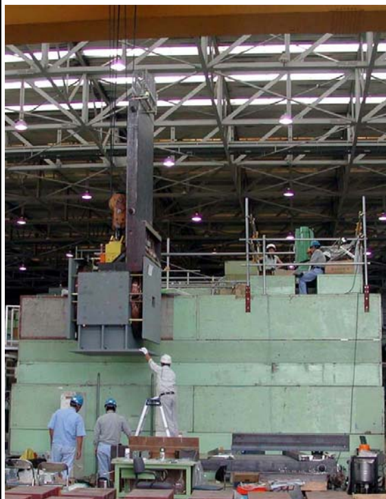
写真：東カウンターホールのモックアップで、耐放射線電磁石の遠隔設置の試験を行っている。
