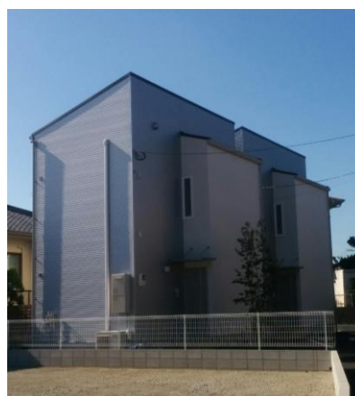
写真 1 実証住宅の外観
