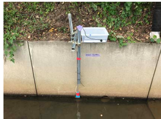
図9 現地試験の様子
