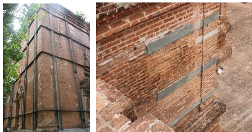
図 2 鉄骨や RC による補強
