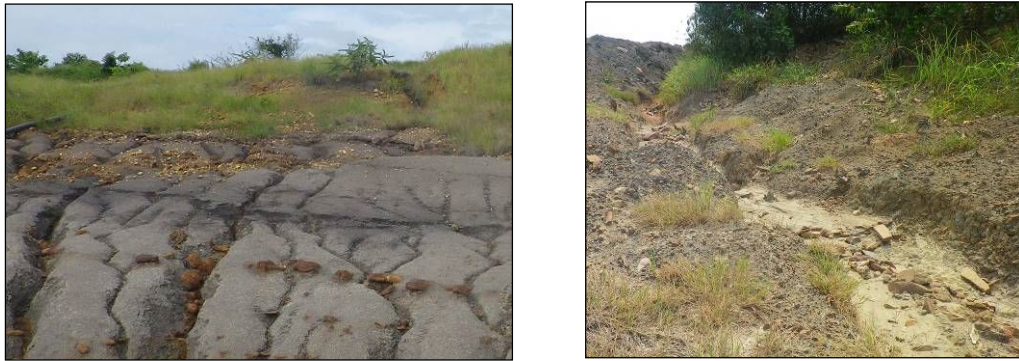
図3 露天掘り石炭鉱山の堆積場における(左)土壌侵食と(右)AMDの発生により植物が枯死している様子
