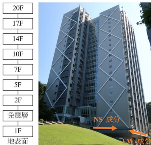
図 5 高層免震建物 J2 棟の微動測定
