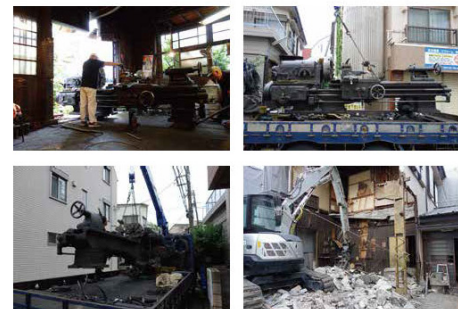
図 2 参考 解体撤去される機械と町工場
