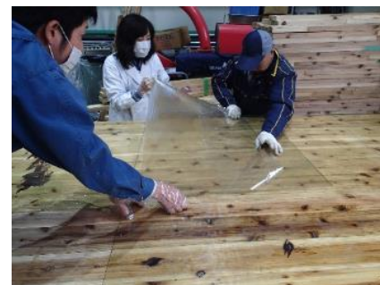
写真3 FRPシートによるラッピング
