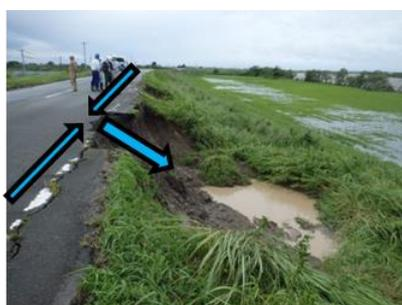
図 1-1 筑後川堤防の法面すべり
