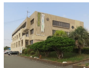
写真1 建物外観 (視点：南東)
