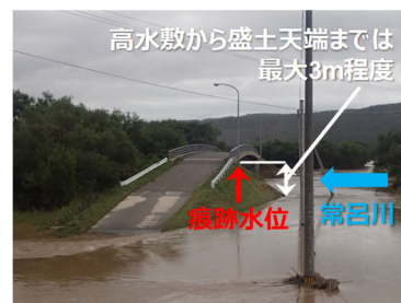
図-3 共立橋の浸水状況
