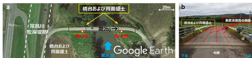
図-2 共立橋の平面図および橋台背面盛土の状況(Google Earth に加筆)
