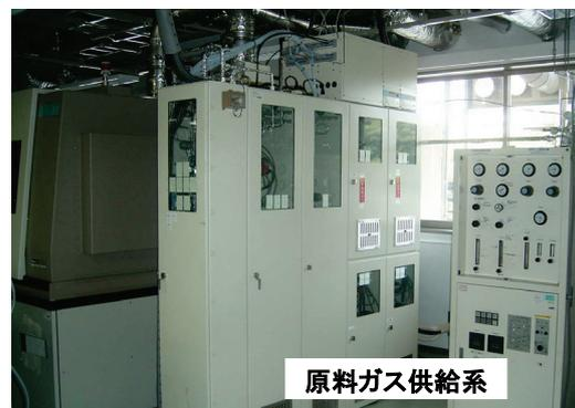
図5 Ga、Al、In の有機金属原料供給系、アンモニア供給系およびキャリアガス水素、窒素の供給系。
