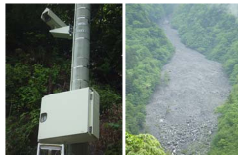
図9 ボッチ薙の斜面流動観測システム
