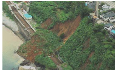
図 16 新潟県中越沖地震 JR 青海川駅斜面崩壊現場の航空写真(朝日航洋(株))
