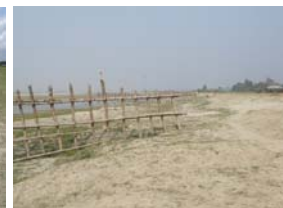
図8 Jamuna川でのバンダル水制の設置(洪水後の平成22年1月撮影)
