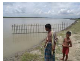
図7 Jamuna川でのバンダル水制の設置(洪水前の平成21年7月撮影)
