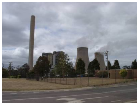
図4 Loy Yang Power site
