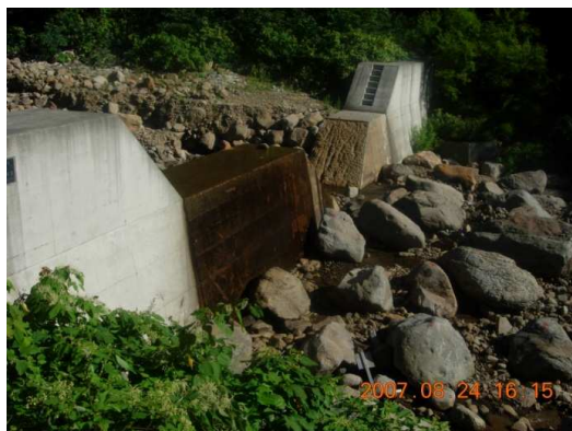
図4 既存ダムの切り下げ試験(留萌管内丸平の沢)
