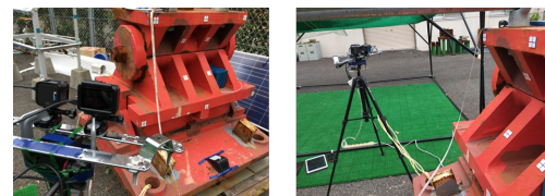
図-4 支承装置及び変状抽出
