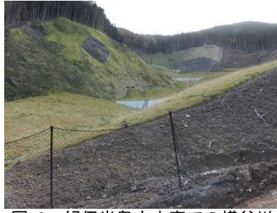
図-9 紀伊半島大水害での横谷川崩壊地（2019/11/13撮影）
