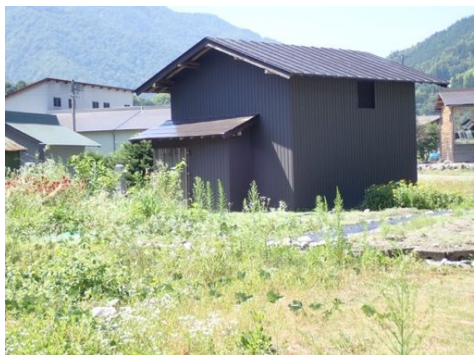
写真1 外壁を覆った元合掌の板倉
