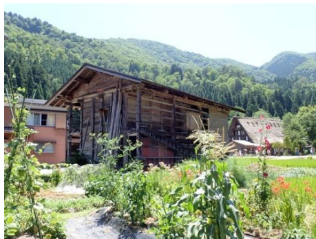
写真2 軸部が残る元合掌のハサ小屋
