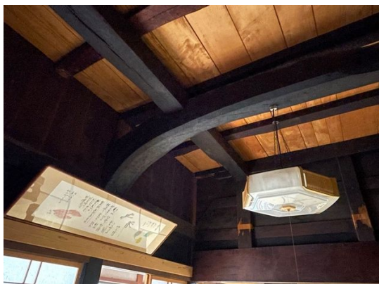
写真3 M家の梁（ウシノキ）
